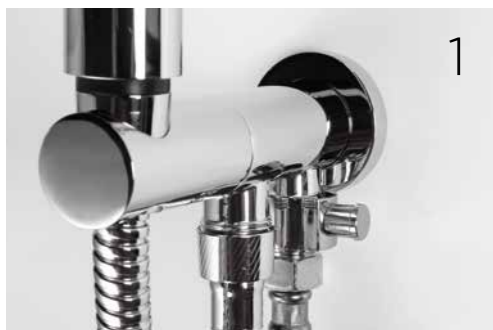
Con la llave de escuadra abierta se suministra agua al WC.
