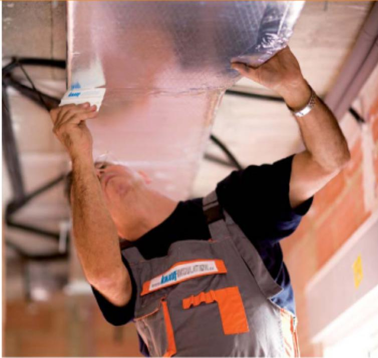
Montaje en obra de una red de conductos CLIMACOUSTIC
